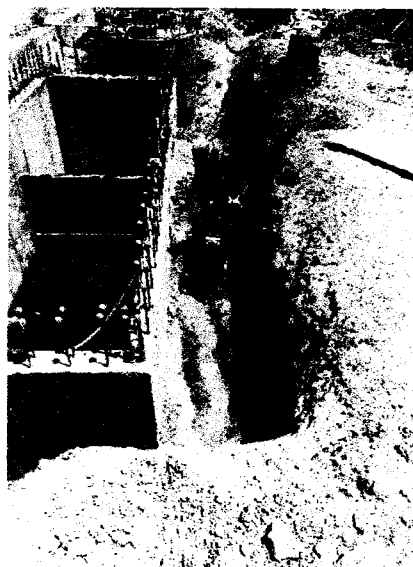
FOTO N°3: Se realizan los trabajos de compactación de material propio en el perímetro exterior del tanque séptico.
