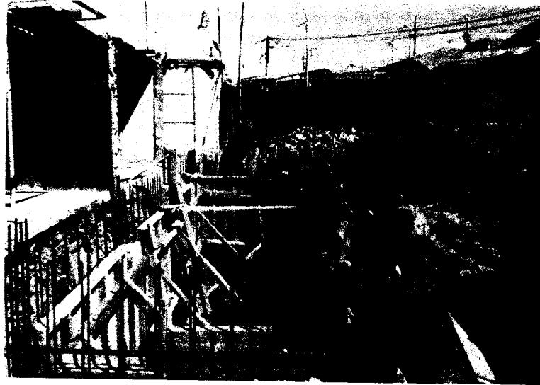
FOTO N°25: Se realizan los trabajos de encofrado para tanque séptico del desagüe doméstico.
