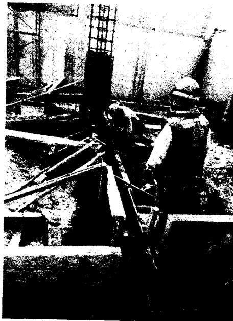
FOTO N°16: Se realizan los trabajos de fundido de concreto para viga de cimentación. Área de Frío.
