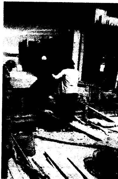
FOTO N°26: Jefe de Supervisión verificando los trabajos de fundido de concreto para viga de cimentación. Área de Frío.
